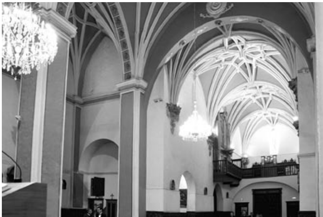
4. Ablitas. Iglesia parroquial de Santa María Magdalena, interior con la zona de encuentro entre la nave de hacia 1540-1544 y la nueva cabecera erigida a partir de 1594. Foto Carlos Beceril.
