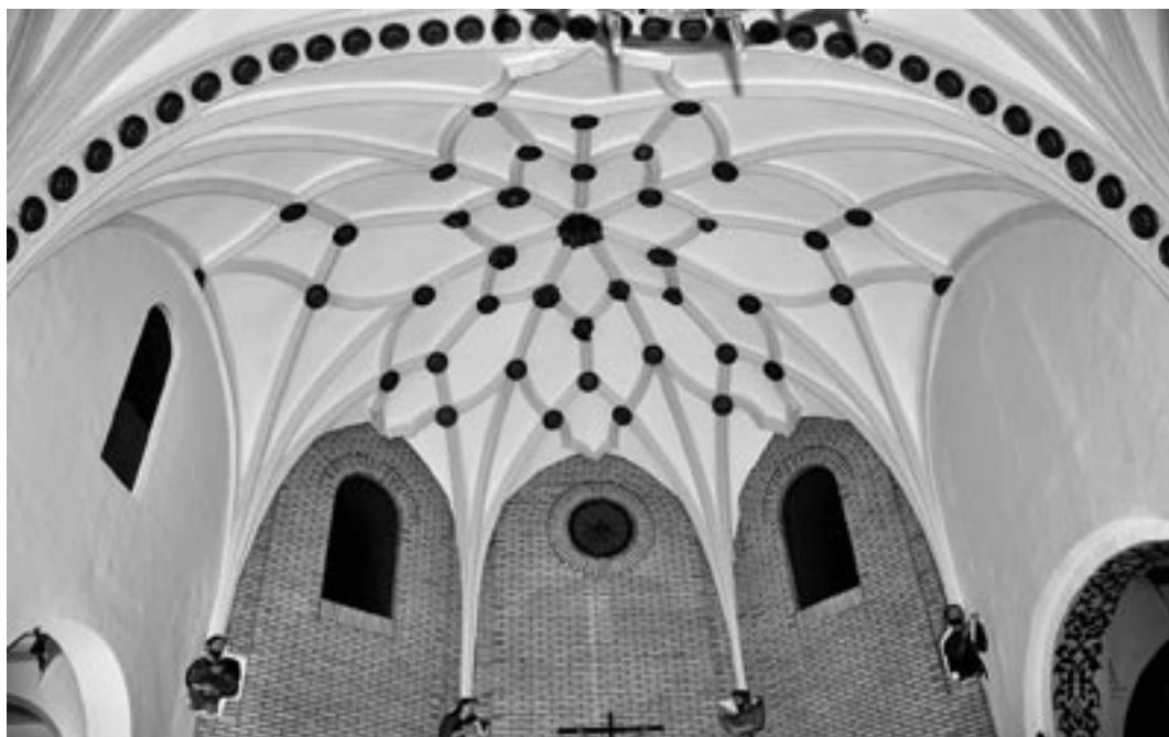
13. Malón. Iglesia parroquial de San Vicente mártir, bóveda de la capilla mayor. Francisco Guarrás (atribuido), hacia 1580-1585. Foto Carlos Becerril.
