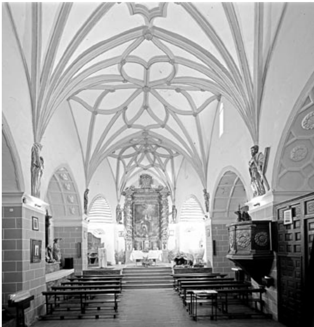
9. Los Fayos. Iglesia parroquial de Santa María Magdalena, nave. Bocelado de la bóveda y ménsulas figurativas a cargo de Francisco Guarrás y Bernal del Fuego, 1575. Foto José Latova.
